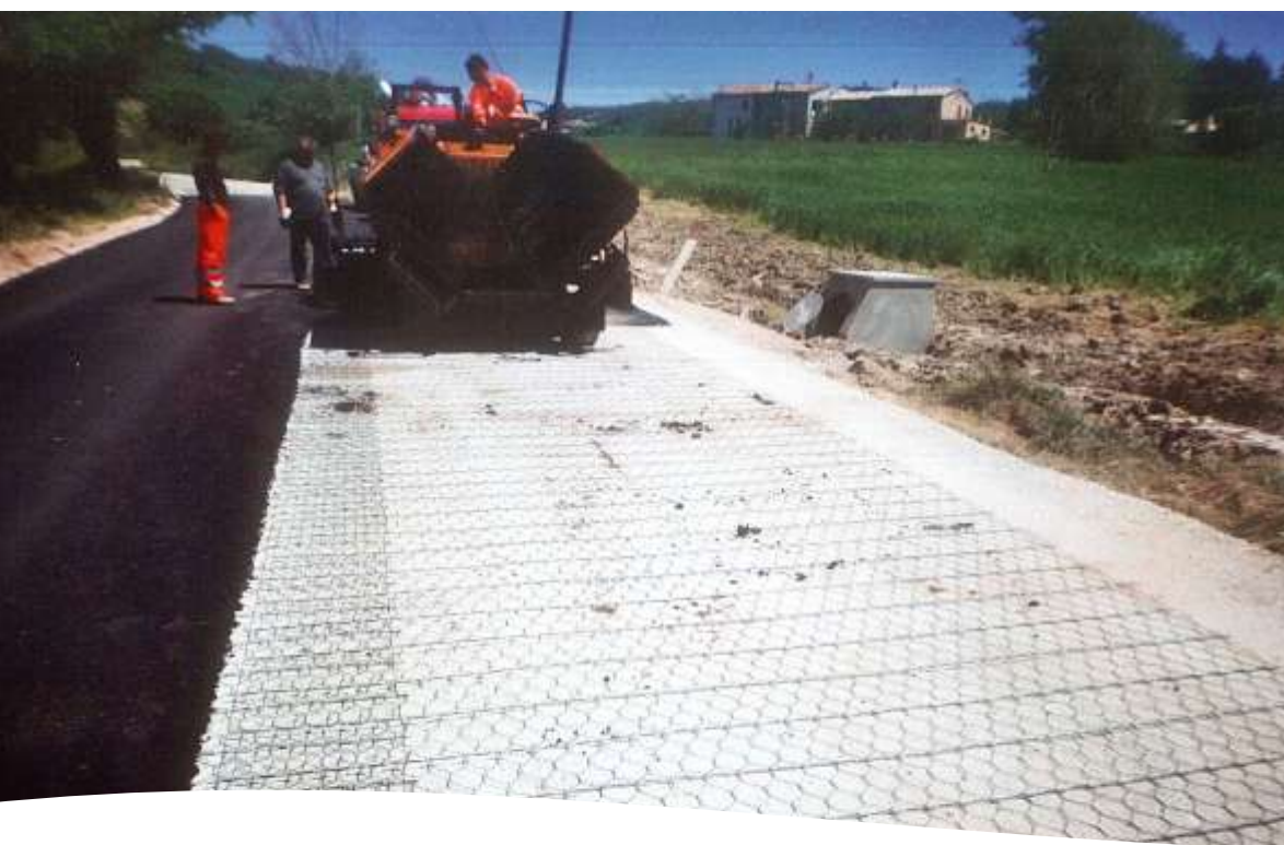
Rafforzamento pavimentazione - SS 77 Val di Chienti
